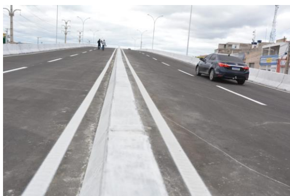
Viaduto da travessia urbana de Petrolina é liberado ao tráfego Crédito: Kléber Lima/Mlnfra
